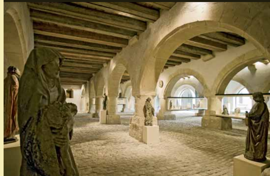
VUE DE L'INTÉRIEUR DU GRENIER DE CHÈVREMONT (1457).
